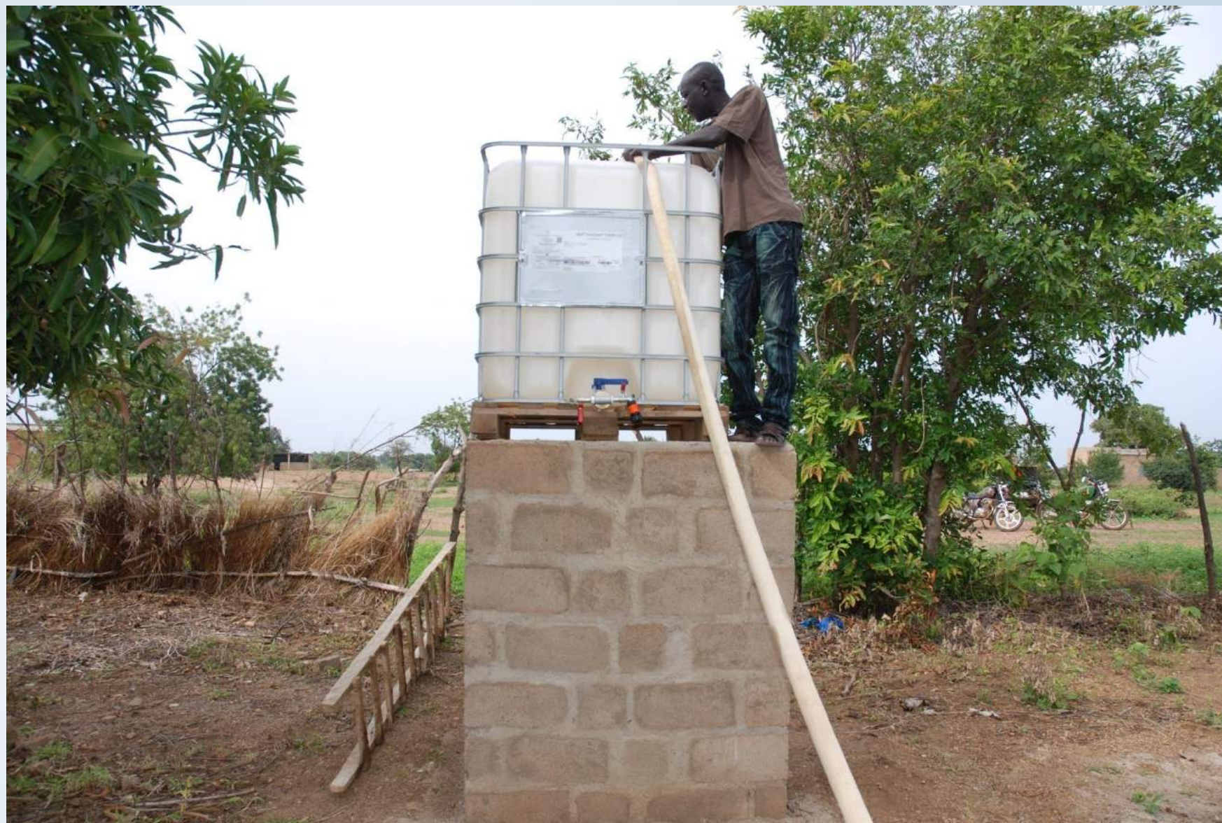
Remplissage du polytank par la moto-pompe
