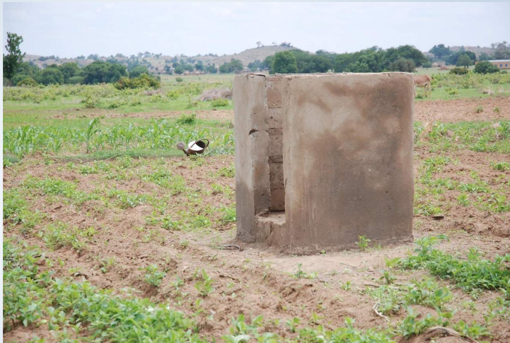
Support maçonnerie du quatrième jardin
