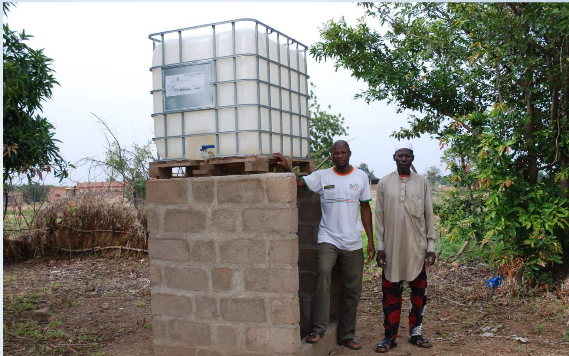
Installation du polytank sur support maçonnerie
