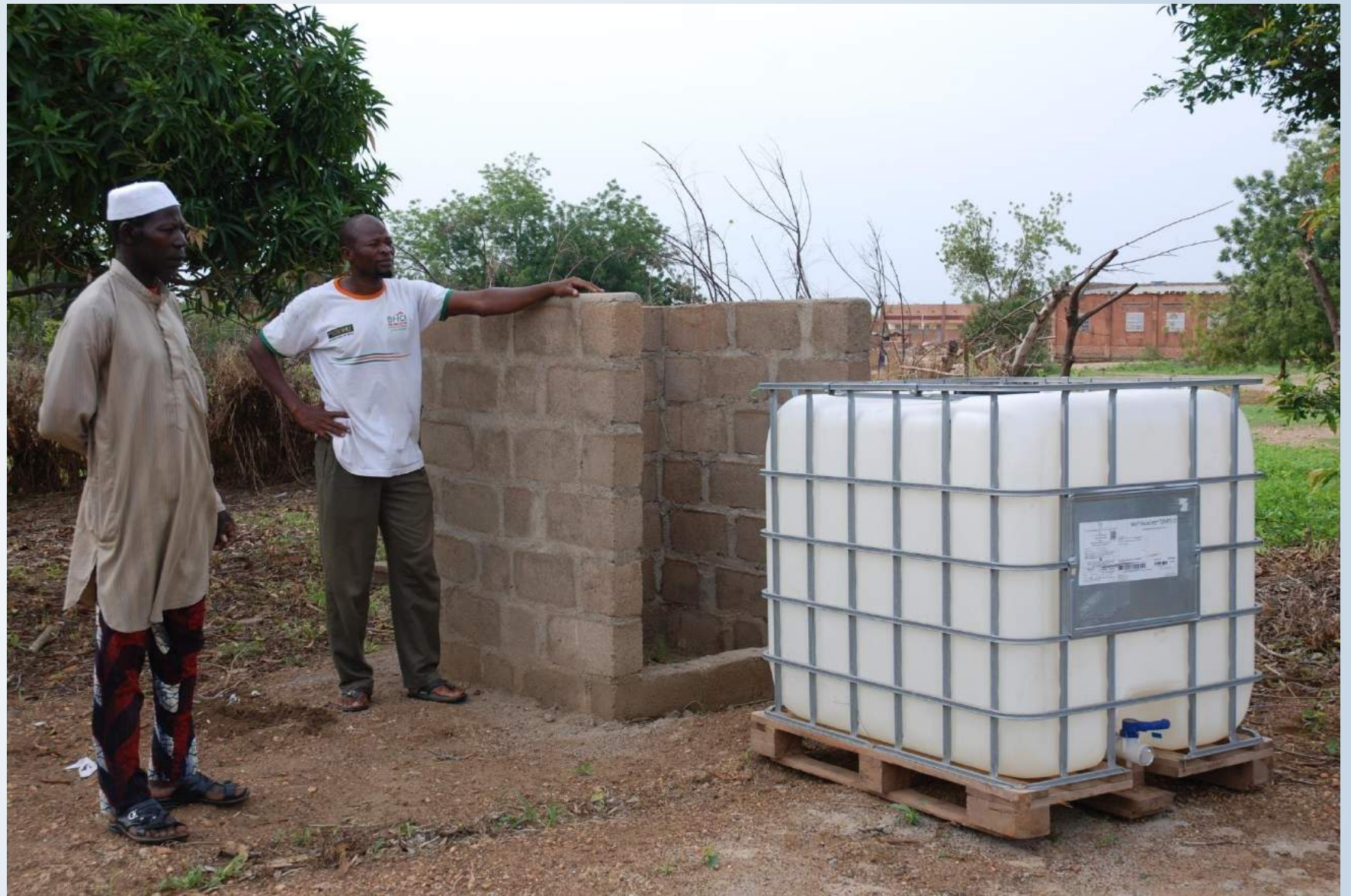
Préparation du polytank dans le premier jardin
