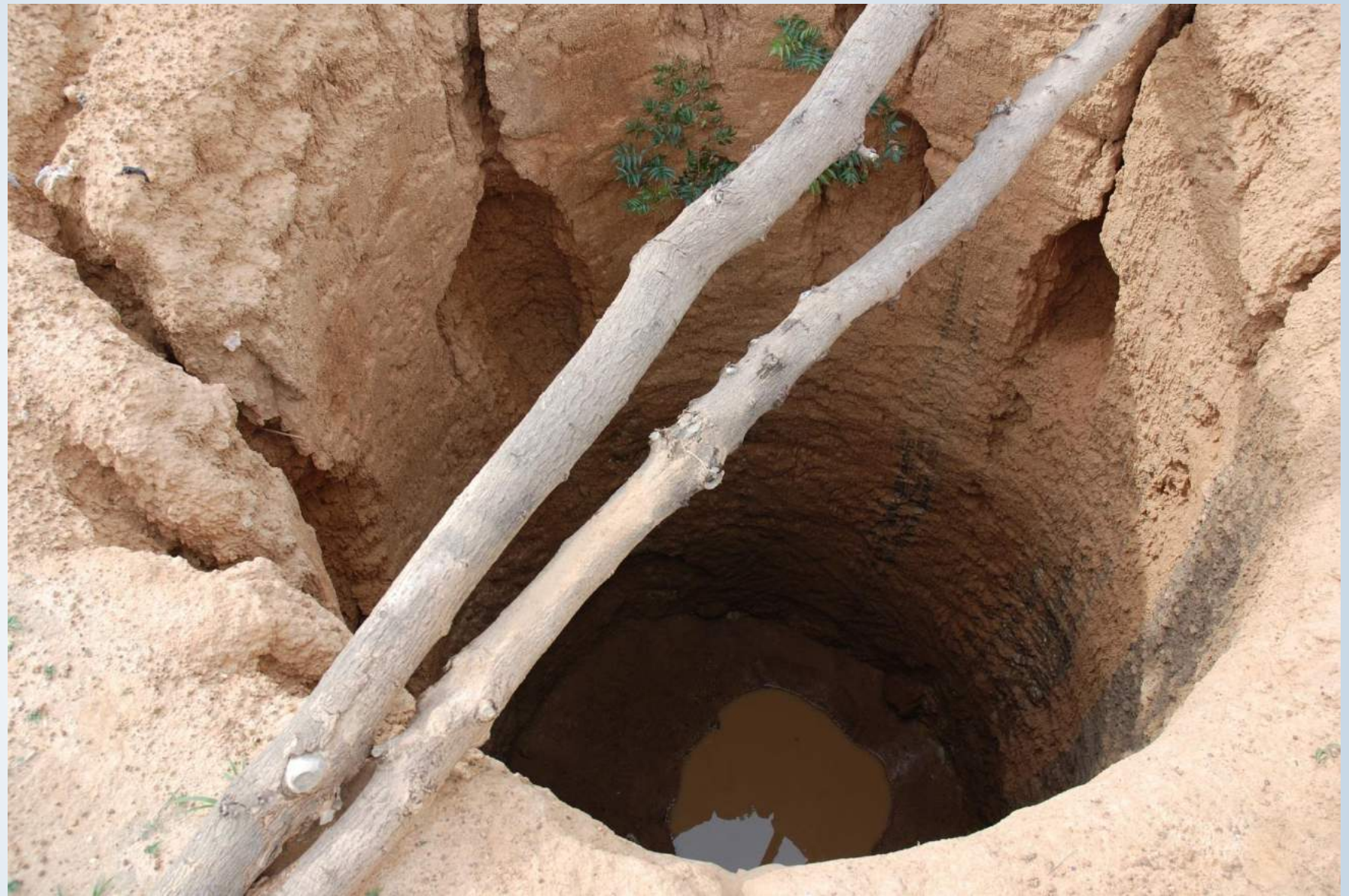
Puits traditionnel sans maçonnerie
