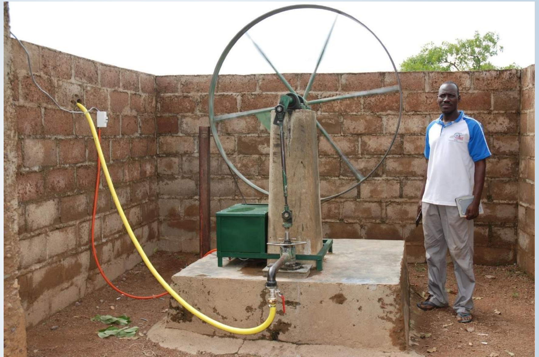
Mise en service de la pompe Volanta avec moteur électrique courroie et vanne de sortie
