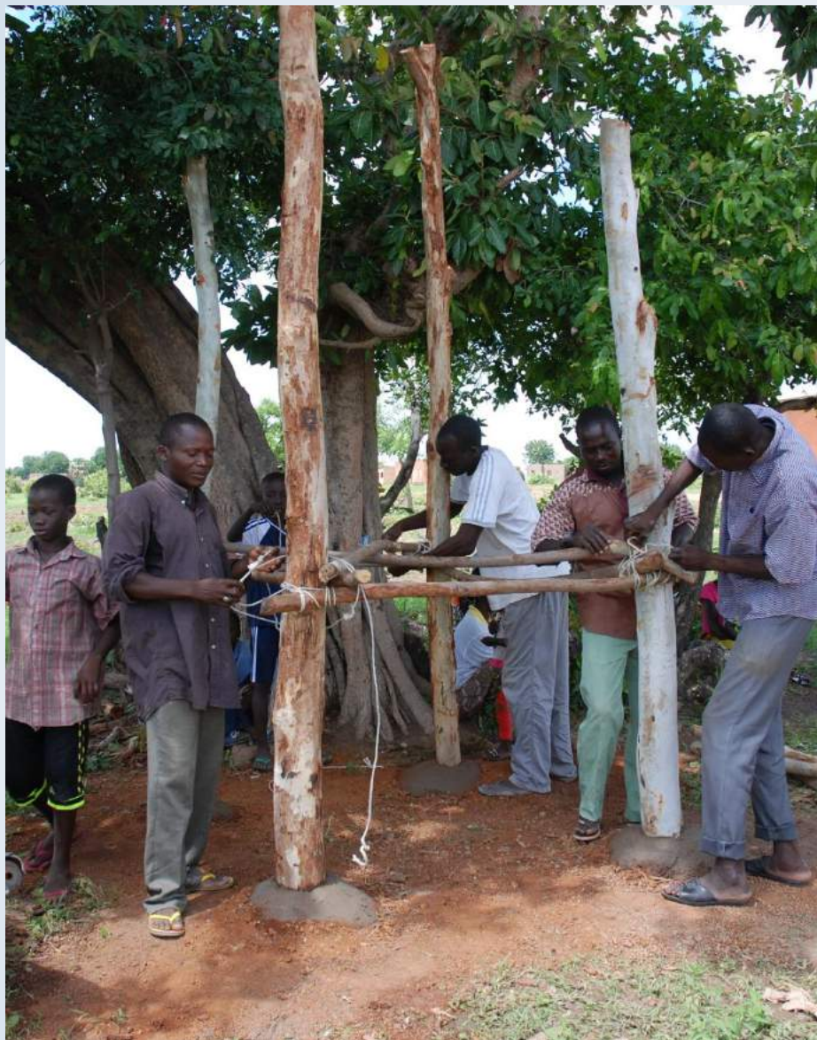
Construction de la charpente provisoire pour la citerne
