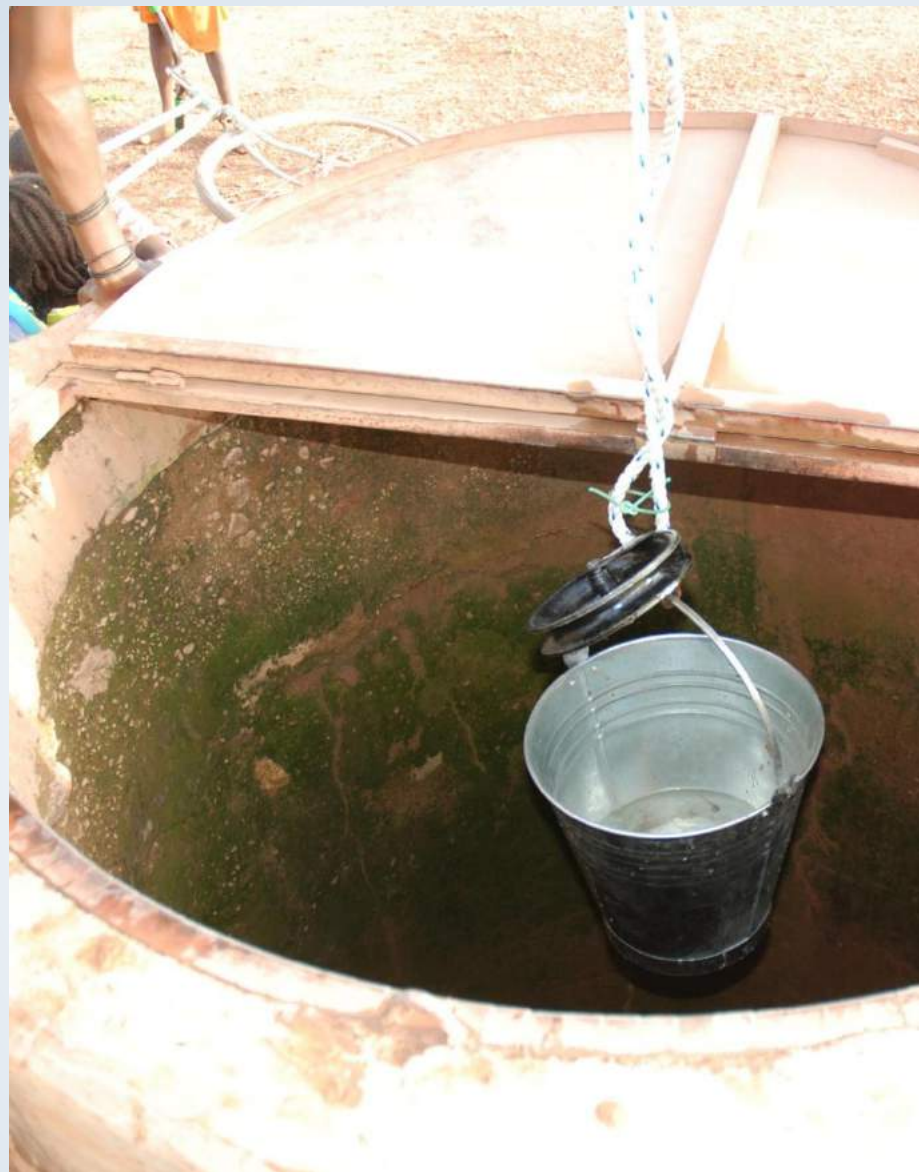
Essai de remontée d'eau du puits avec double poulie
