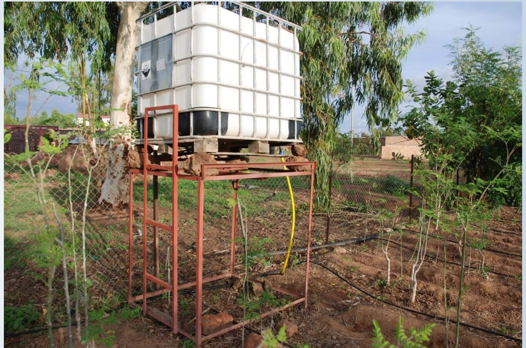
Alimentation du réseau de goutteurs sur le polytank existant
